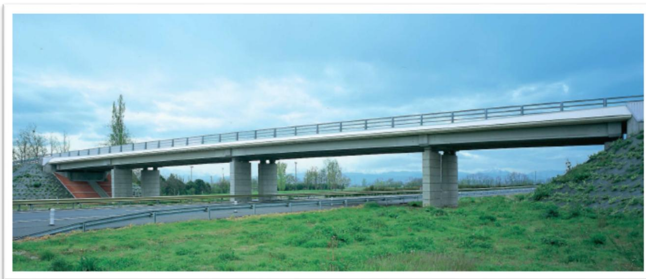
Figure I. 4: exemple pont à poutres
