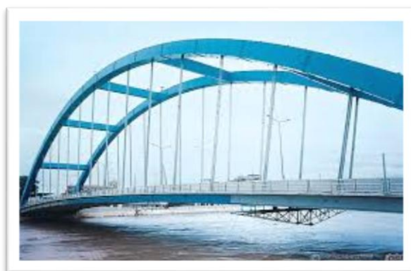
Figure I. 5: exemple pont en arc
