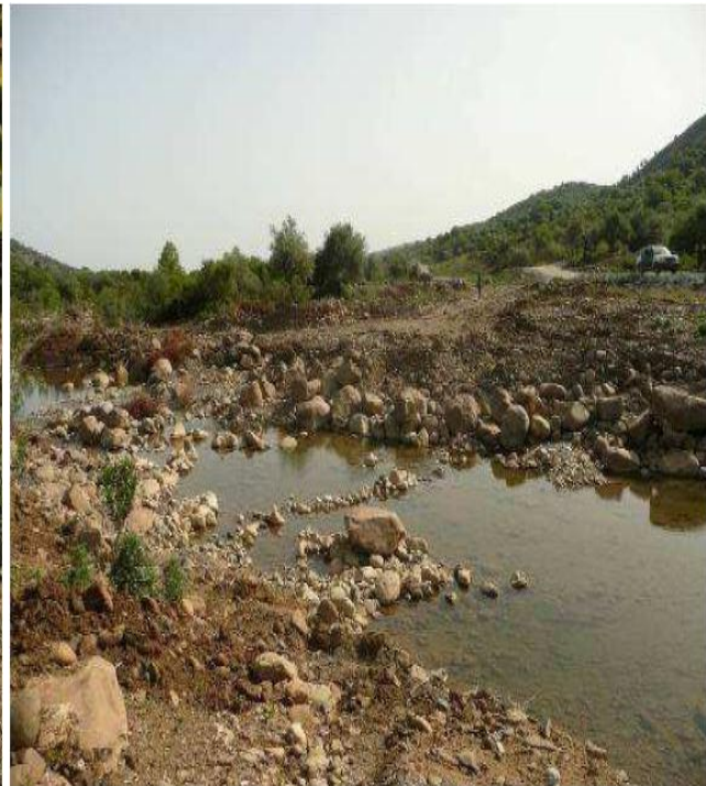
Figure II.2 : Formations géologiques présentes dans le site du viaduc (dépôts quaternaires).
