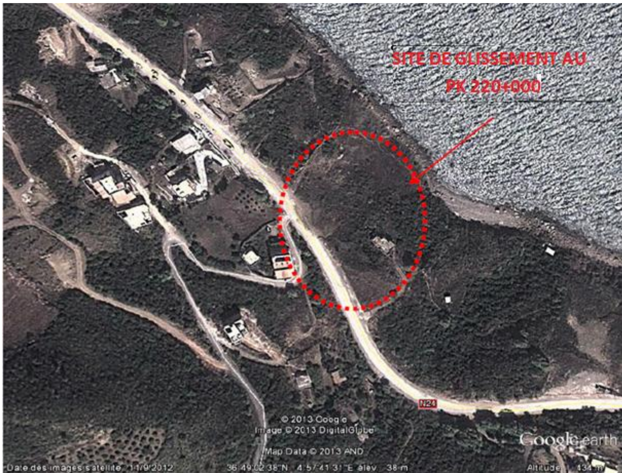
Figure 5-1 Situation géographique du site de glissement [17]
