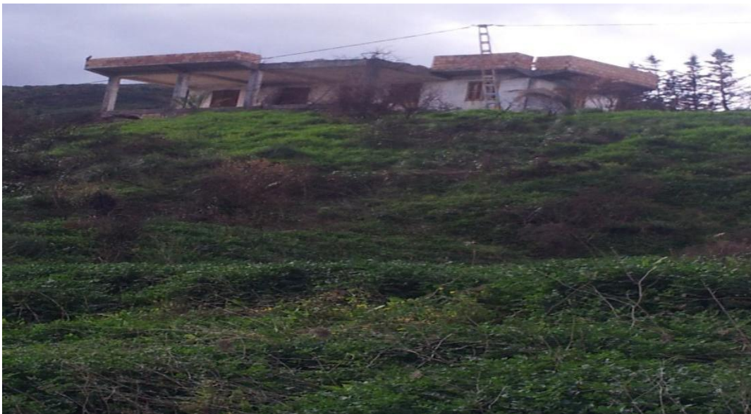
Figure 5-5 Basculement de la bâtisse située sur la crête du versant
