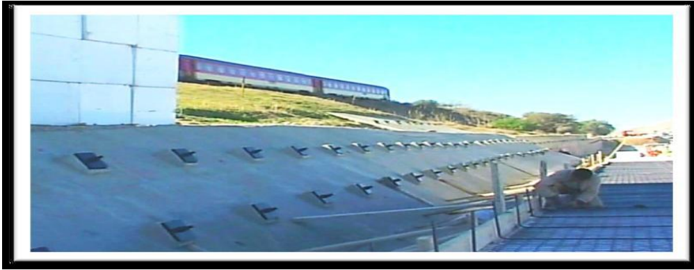
Figure 4-4 Stabilité d'un glissement avec tirant d'ancrage [9]
