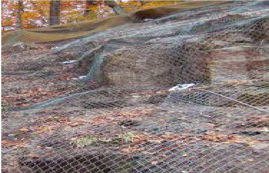
Figure I. 25. Grillage plaqué métallique.
