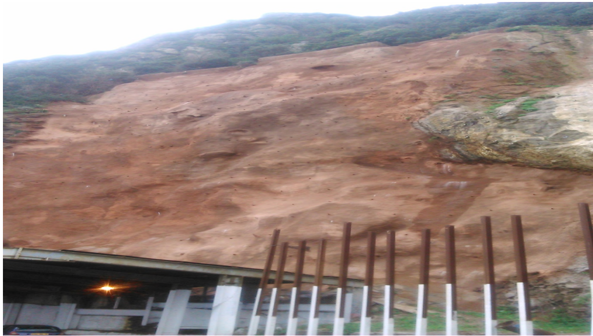
Figure I. 21. Massif rocheux renforcé par le béton projeté à Aokas.
