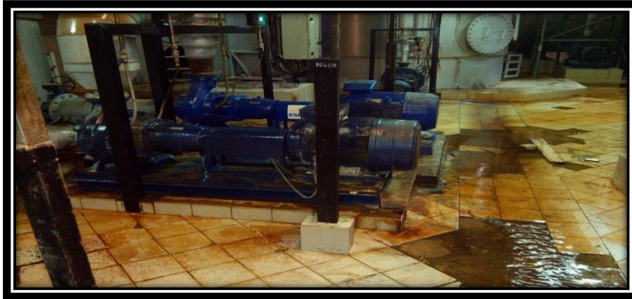
Figure IV.2. Problème d'étanchéité.
