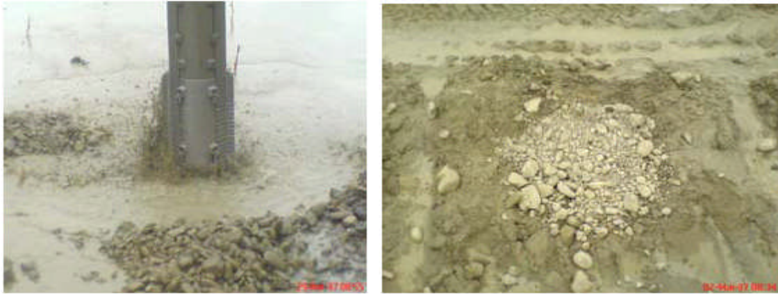
Figure –I-10- : Finition d'une colonne ballastée (barrage Kessir, Jijel). [1]
