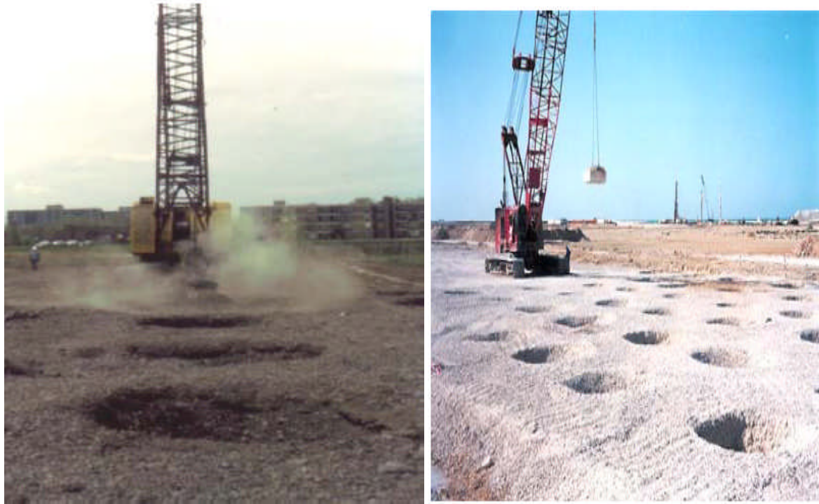
Figure –I-5- : Exemple d'un chantier de compactage dynamique. [1]
