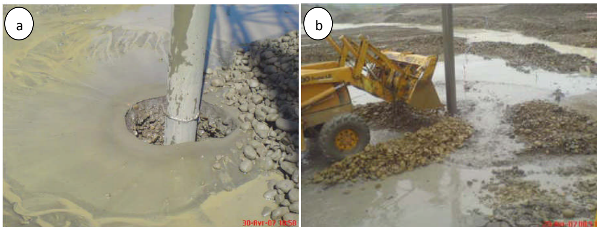
Figure –I-9- : -a-Phénomène de liquéfaction locale (site : barrage Kessir ; Jijel). [1]
