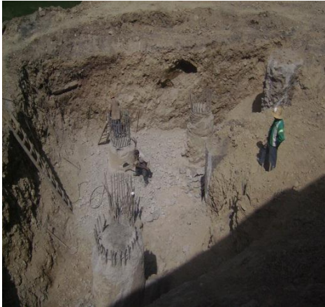
Figure 8.5. Le recepage des pieux
