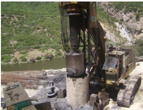
Figure 8.1. Le forage des pieux d'armature
