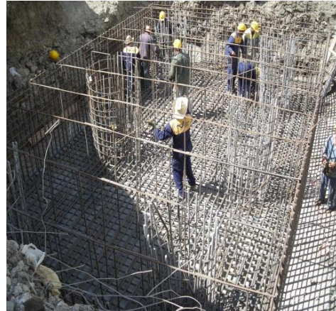
Figure 8.6. Ferraillage de la semelle après le recepage
