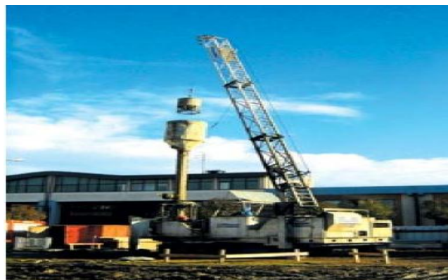
Figure 6. La machine spécialement conçue pour l'exécution complète des pieux vissés moulés (Technique de l'Ingénieur)
