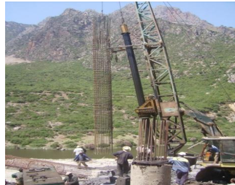
Figure 8.2. Mise en place de la cage
