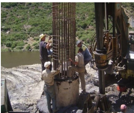
Figure 8.3. Le renforcement de la zone de recouvrement
