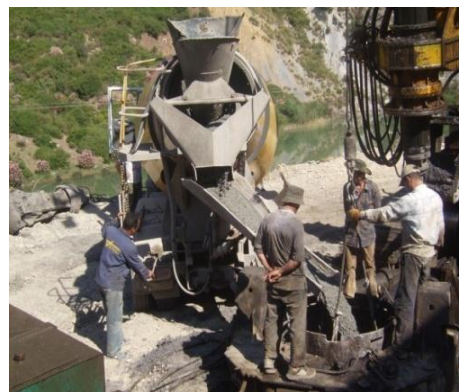
Figure 8.4. Le bétonnage à l'aide du tube plongeur
