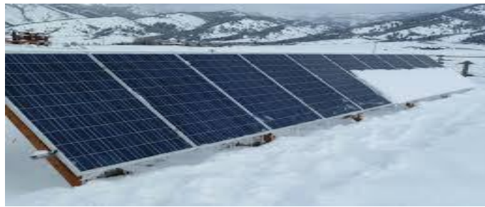
Figure III.8: A-Module PV couvert et ombrage par la neige.
