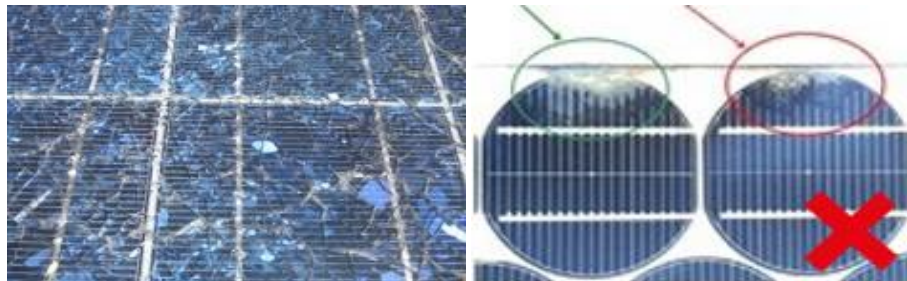
Figure III.9: Module PV couvert et ombrage par la poussière.
