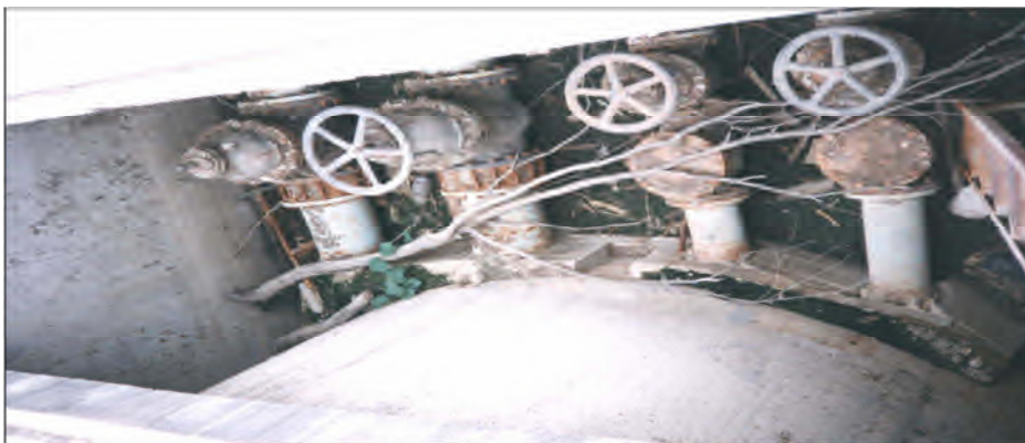
Figure III.4 : Vue rapprochée de la chambre de vanne
