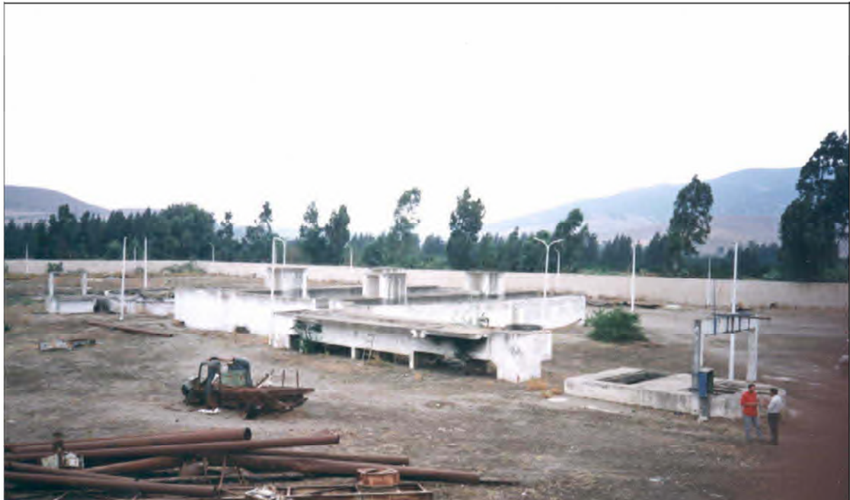
Figure III.2 : Vue générale de la STEP
