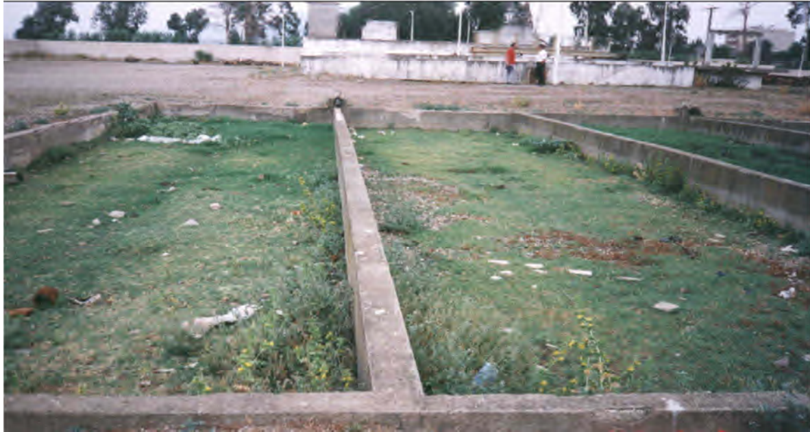
Figure III.8 : Vue rapprochée sur un lit de séchage
