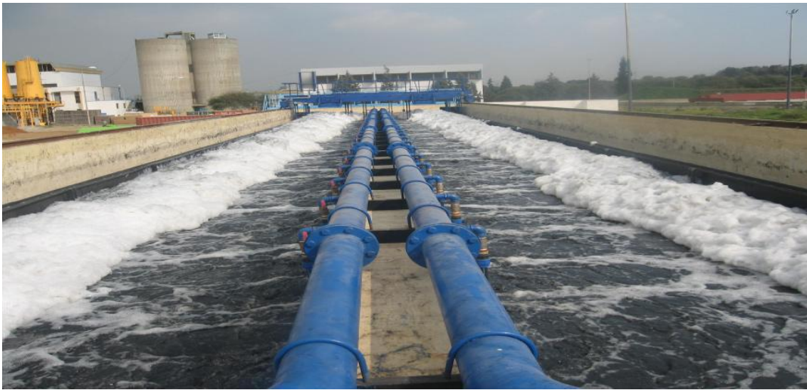
Figure (III.3) : déshuileur dégraisseur de la STEP de BARAKI
