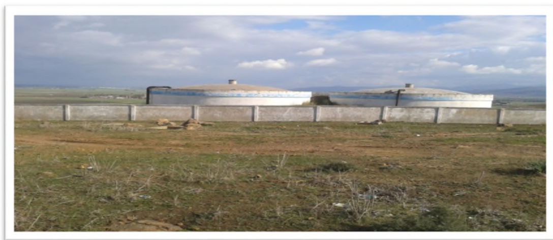
Image (III.4) : Réservoir 2*1000 m 3
