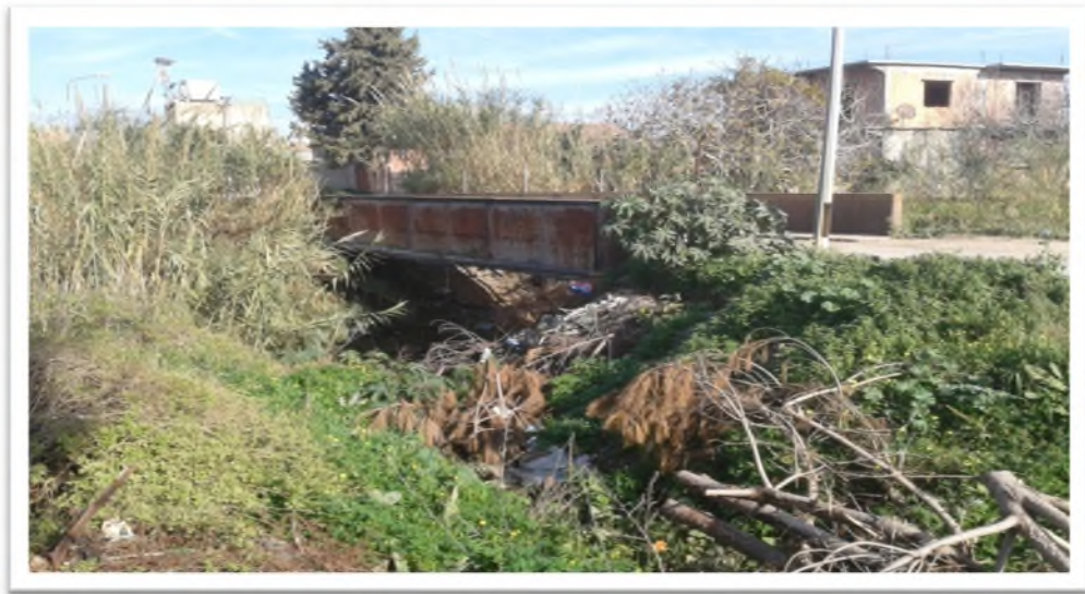
Image (III.13) : La conduite d'AEP traverse l'oued
