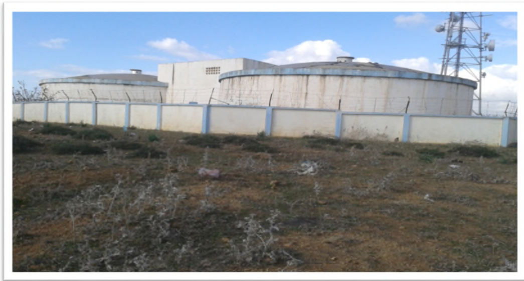
Image (III.3) : Le réservoir tampon 2*1000 m 3
