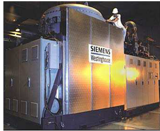
Figure 1.7 : Installation Siemens Westinghouse utilisant une SOFC atmosphérique de 220 kW
