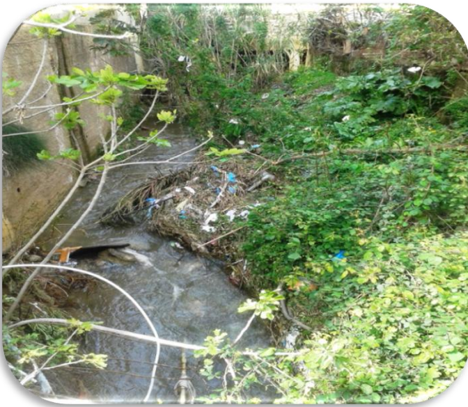
Figure II.14: Protection par un mur de soutènement en béton armé d'un seul côté
