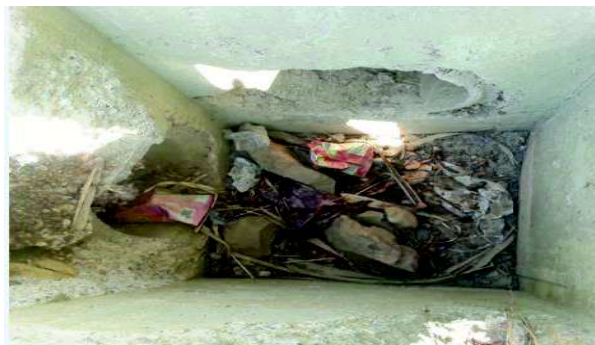
Figure (III-10): Regard détruit
