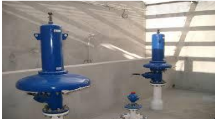
Figure (V.3): Soupape de décharge
