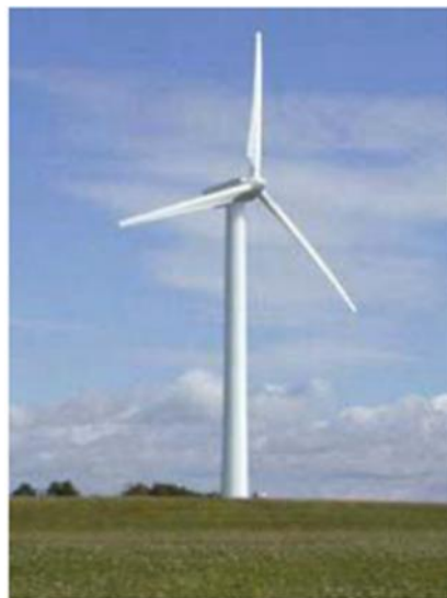
Figure 1.4. Éolienne à axe horizontal.
