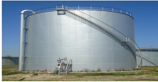
Figur I.8 : Bac de détente 4Y1
