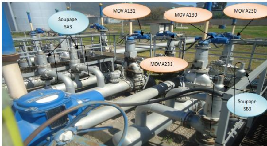
Figure I.6 : Constitution de la troisième section de la batterie des soupapes
