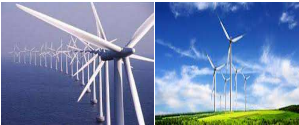
Figure I.5 : Les éoliennes Offshore Figure I.6 : Les éolienne On shore
