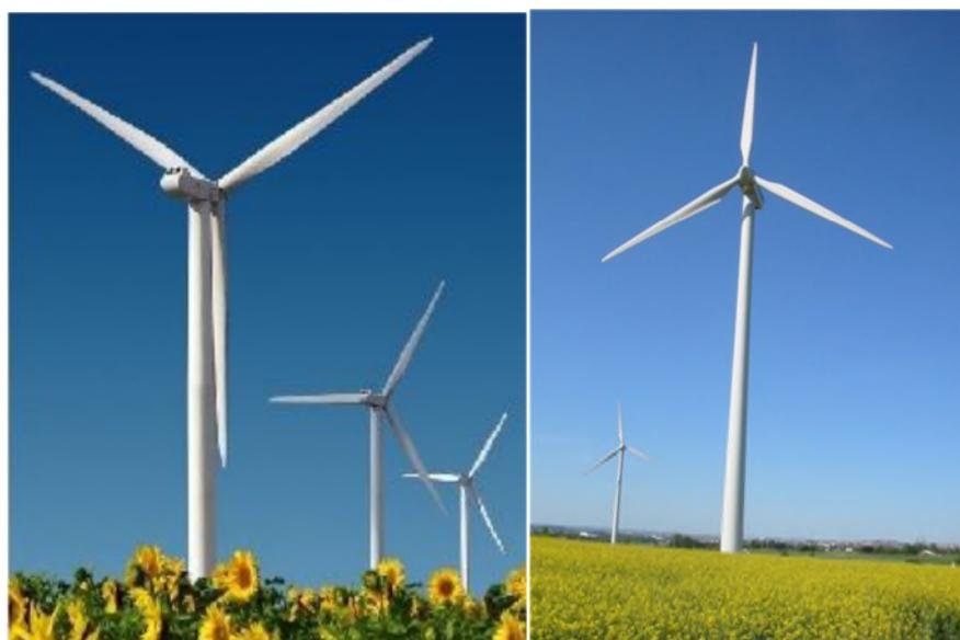
**Figure 1.4.3** : éolienne à axe horizontal
