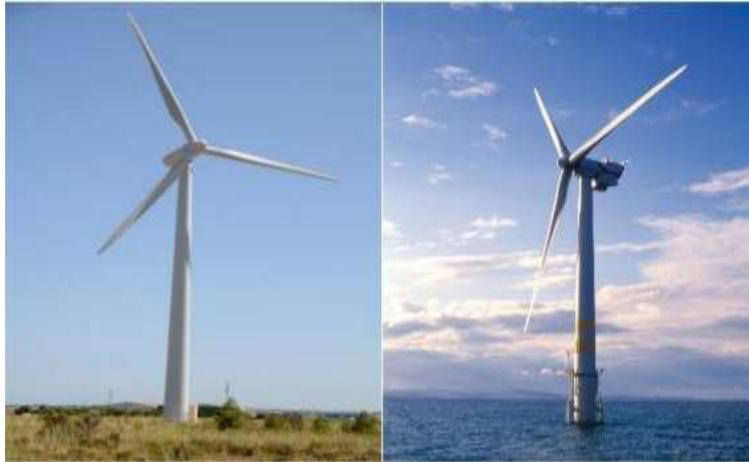
Figure I.5 : Eolienne à axe horizontal.
