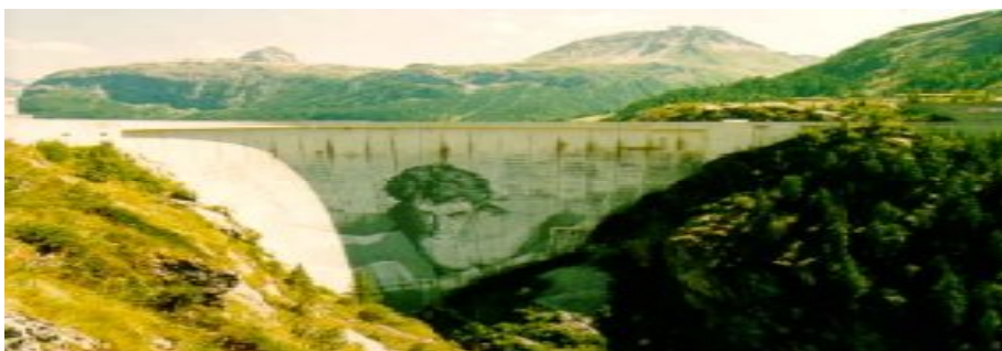
Figure I-5 Barrage de Tignes, le plus haut de France (160 m il retient 230 millions de m 3 ) [3]
