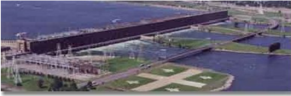
Figure I-4 : Centrale de Beauharnois au Québec : Puissance 1660MW ; hauteur de chute 24m [2]
