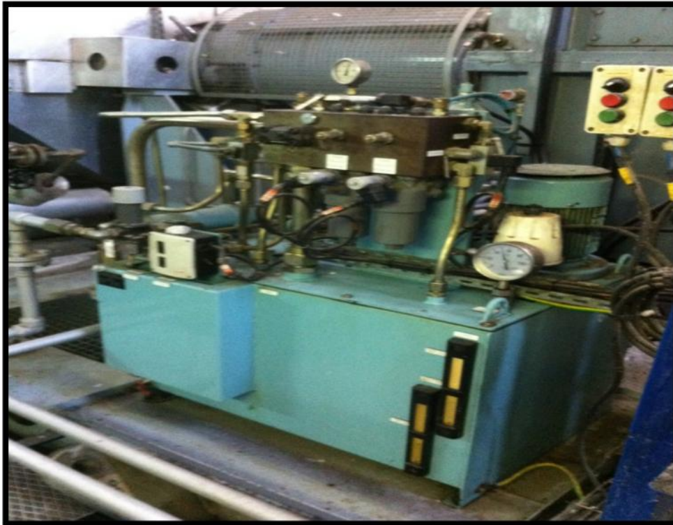
Figure II.12 Réservoir huile HP et ses éléments
