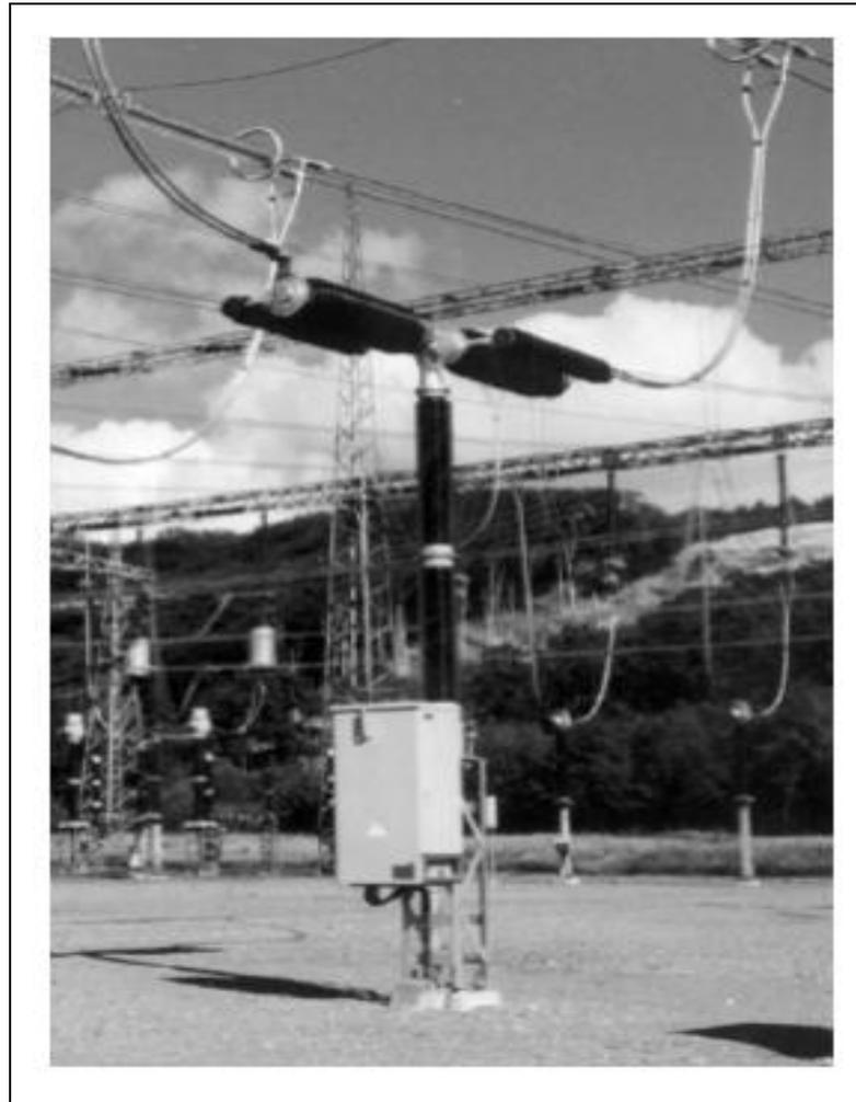
**Fig.1.11** : disjoncteur auto-soufflage
