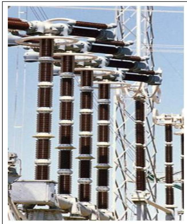
**Fig.1.2** : Disjoncteur à air comprimé (36kV)
