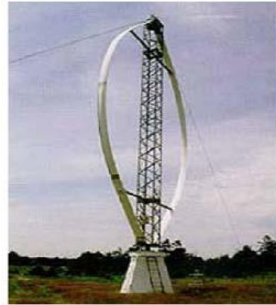
Fig. I.2 Eolienne à axe vertical [Ber 02]
