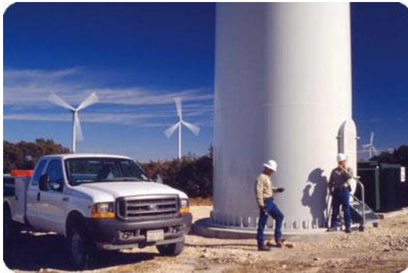
Figure I.2 : Tour d'une turbine
