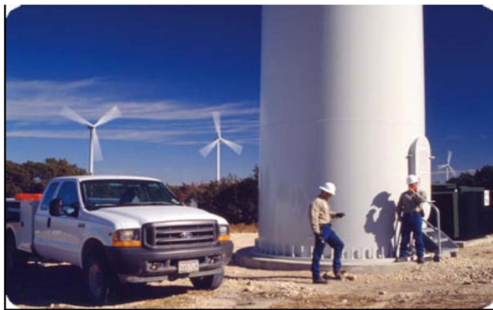
Figure I- 5 : Tour d'une turbine.
