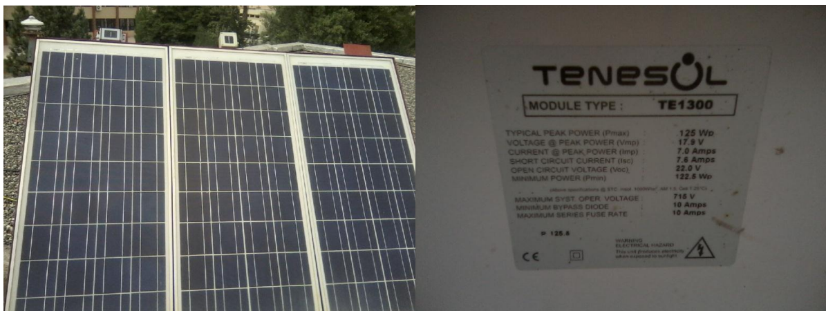
Figure III.1.1 : les Panneaux solaire polycristallin utilisés avec ses caractéristiques
