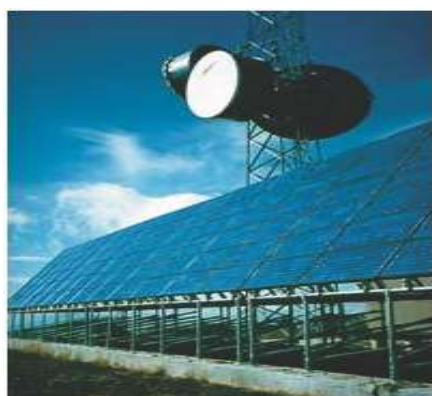
Figure 5.1. Installations photovoltaïques destinées pour l'alimentation électrique des Stations relais de télécommunication
