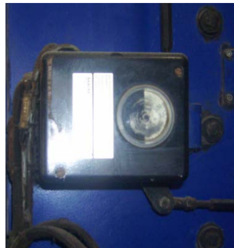
Figure. II.16-Le servomoteur
