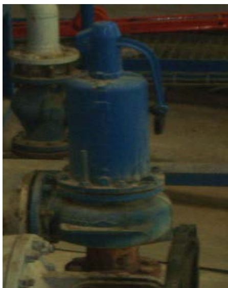
Figure. II.13-Soupape de sécurité
