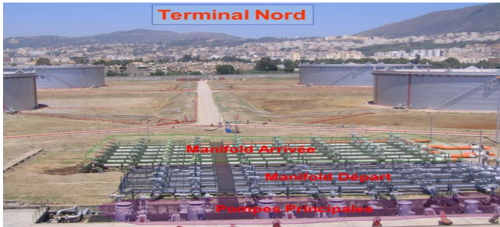
Figure I.12. Manifold au niveau du terminal nord Bejaia
