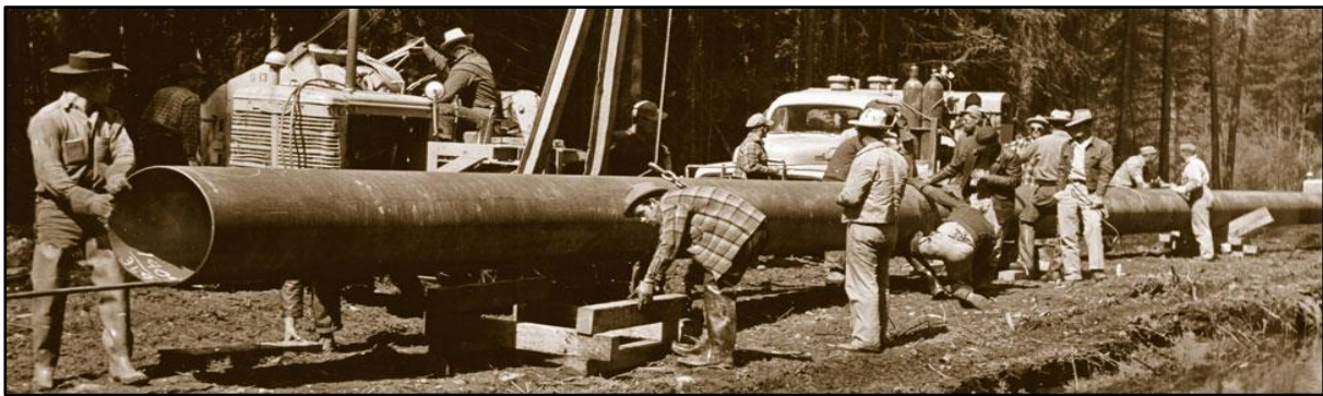
Figure I.1. Réalisation du 1 er pipeline (Archives SONATRACH)
