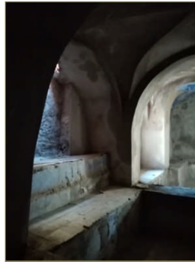
Figure 05 : Piliers portant des voutes.
