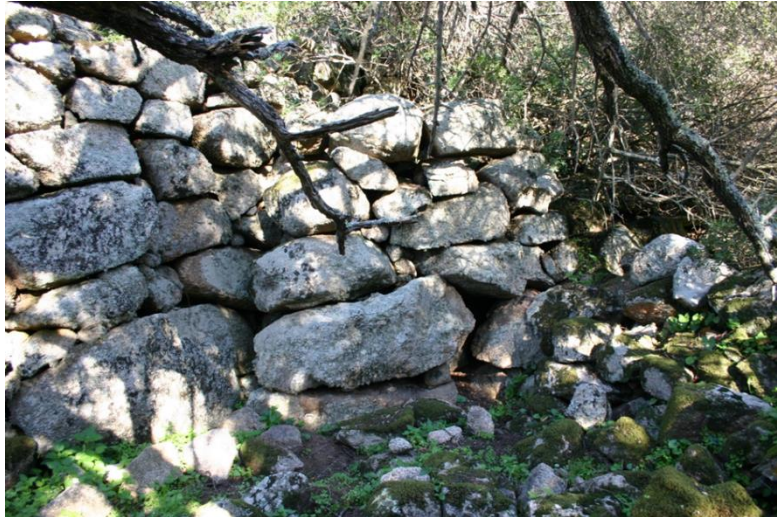
Fig. 13 – Calanchedda, bastion semi-circulaire (au centre) accolé à la courtine de l'enceinte sud (K. Peche-Quilichini)
