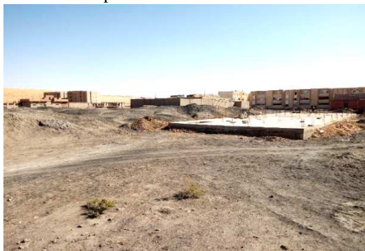
Fig 22. Lotissements d'habitations individuelles à proximité des terrils
