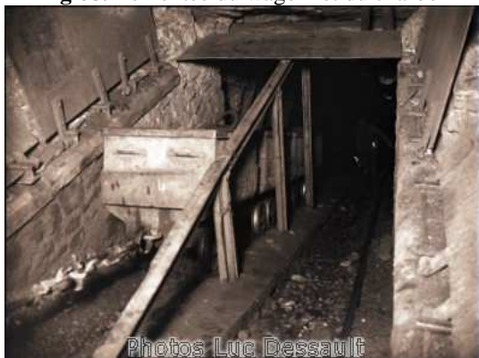
Fig 08. Remontée du wagonnet du charbon
