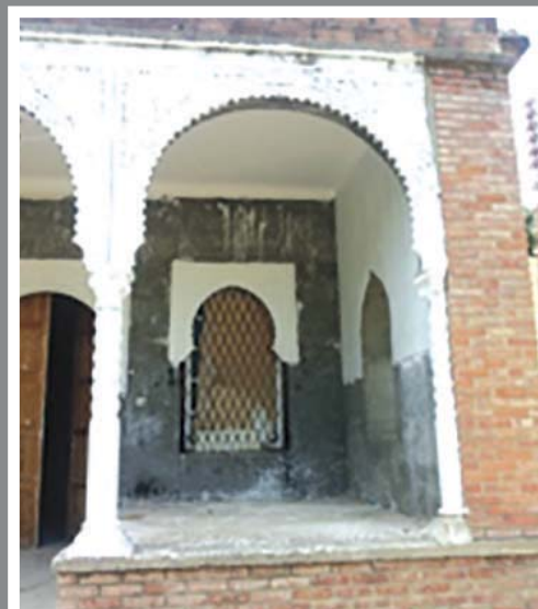
Les éléments de décorations sont préfabriqués en béton
