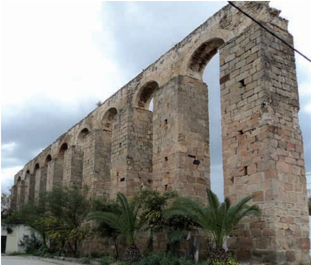
جسر لقنات المياه في الفترة الرومانية أعد إستعمالها في الفترة الحفصية 1267م
