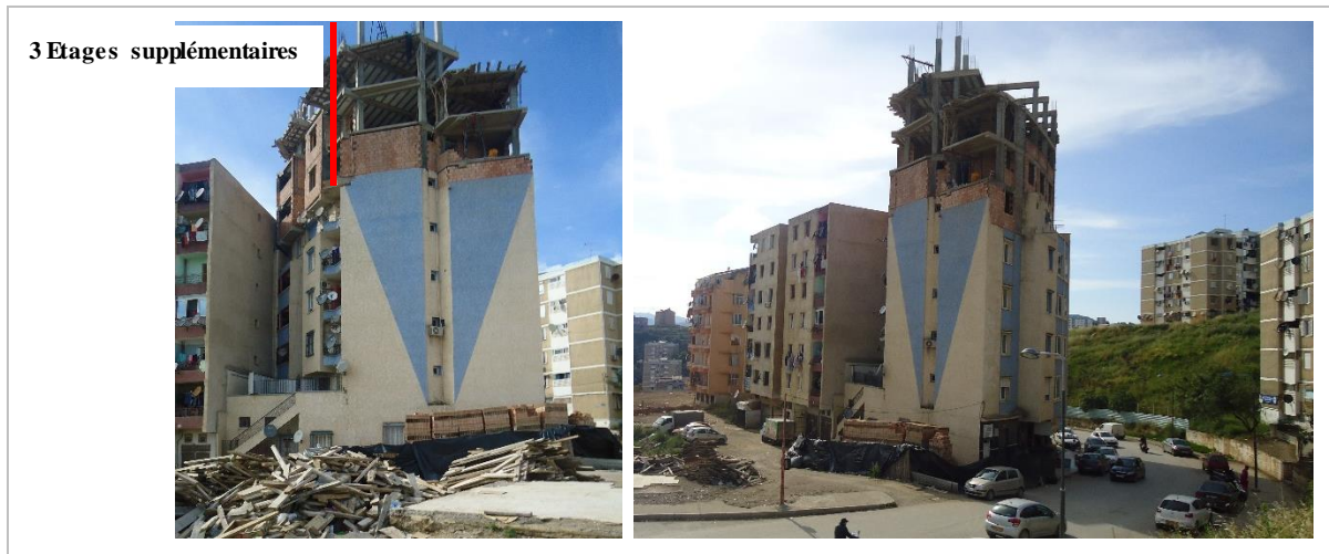
Figure 57 : Densification urbaine de type douce par extension verticale dans le quartier de Sidi Ahmed. Source : Auteurs, 2018.
