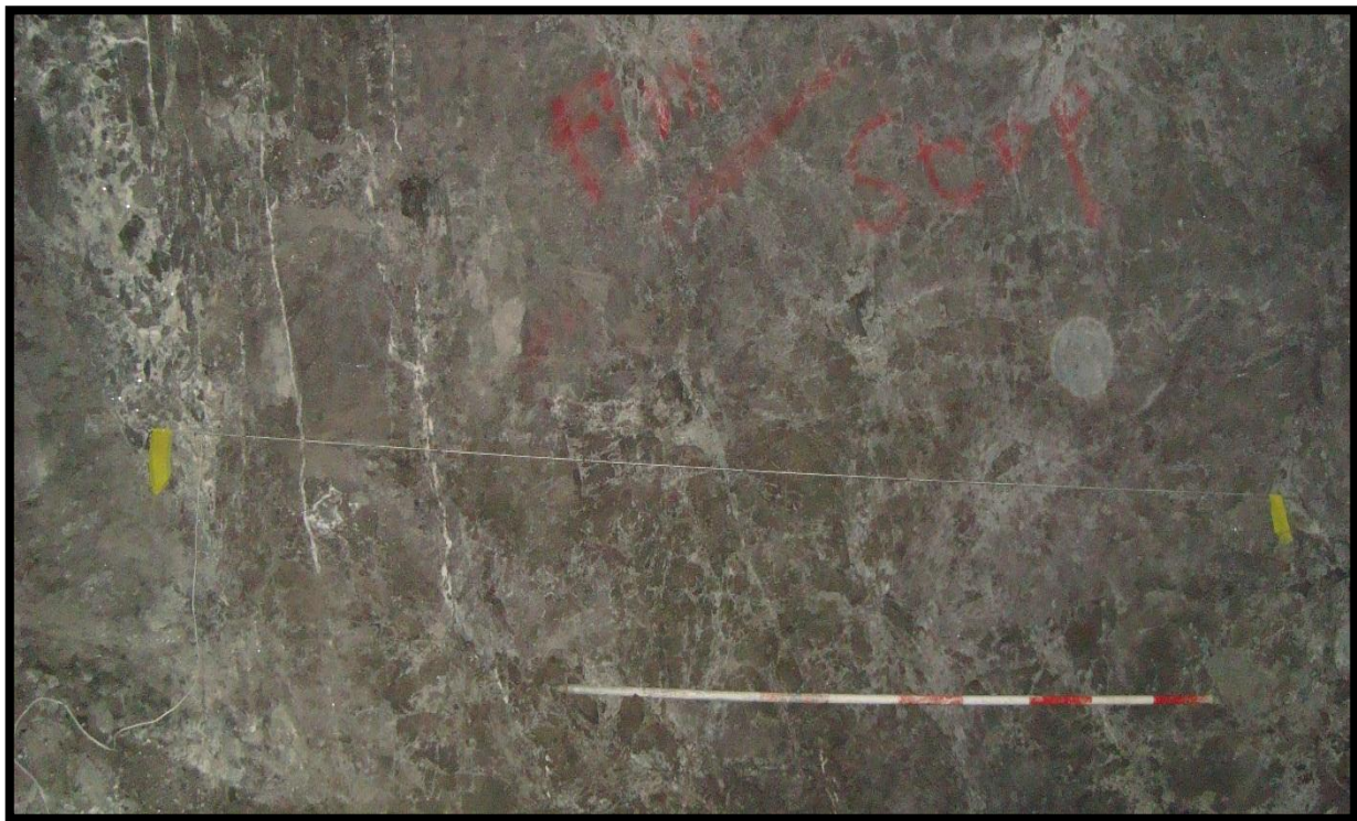
Figure V.2 : Front de taille-Galerie- Profil 13, bloc B5-3 (Chaâbet El-Hamra)
