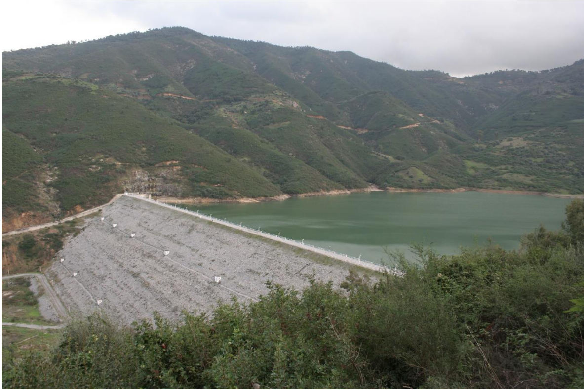
Figure (I-4) : Barrage El Agrem
