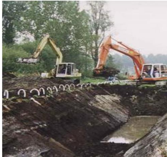
Figure V.7 : Pompes des eaux dans les tranchées.
