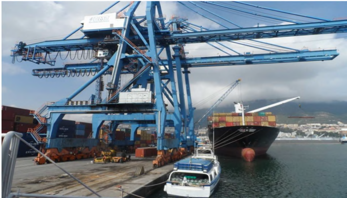
Figure n°16 : Portique de quai sur rail
