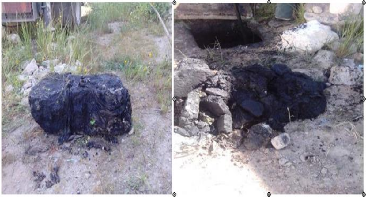
Figure 2.4 : blocs de pierre provoqués par les margines extraits d'un réseau d'assainissement à Fès (Maroc) (Amrani et Bendidi, 2004)
