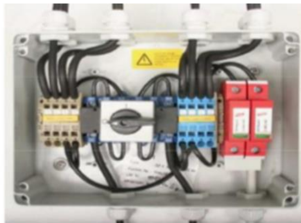
Figure II.23 : Exemple de boîte de jonction et câblage. [15]
