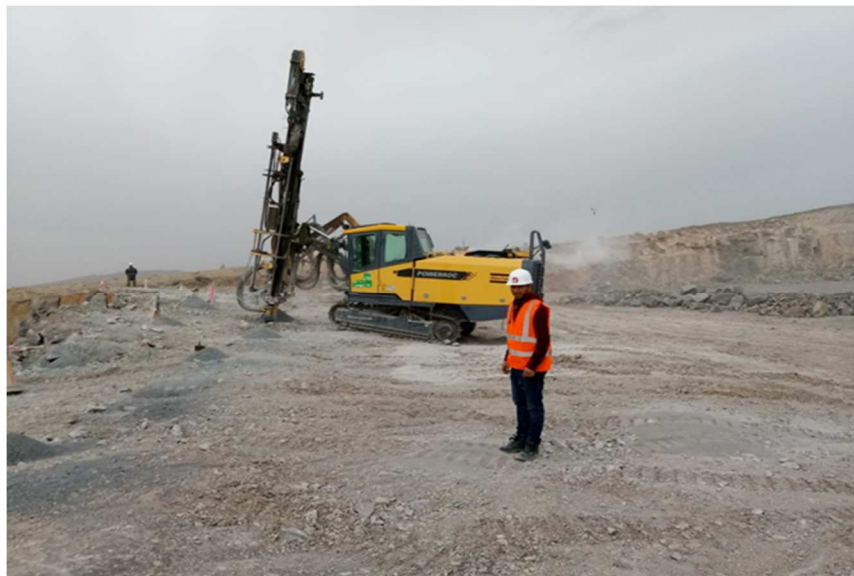
Figure II.3 : Sondeuse ATLAS COPCO.
