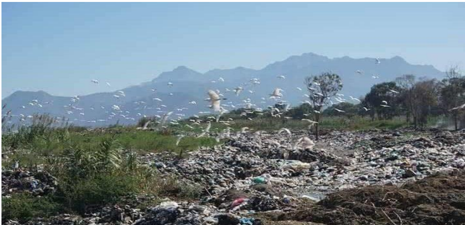
Figure 4 : Décharge publique d'Aokas
