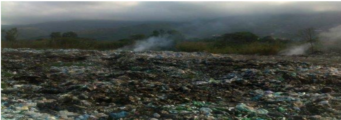
Figure 18 : Décharge publique d'Aokas
