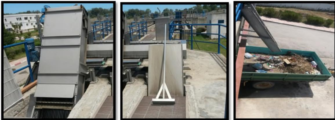
**Figure I.4 :** Grille automatique. **Figure I.5:** Grille manuelle. **Figure I.6 :** Benne
