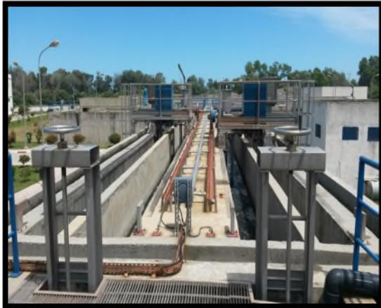
Figure I.7 : Pont déshuilage-dessablage.
