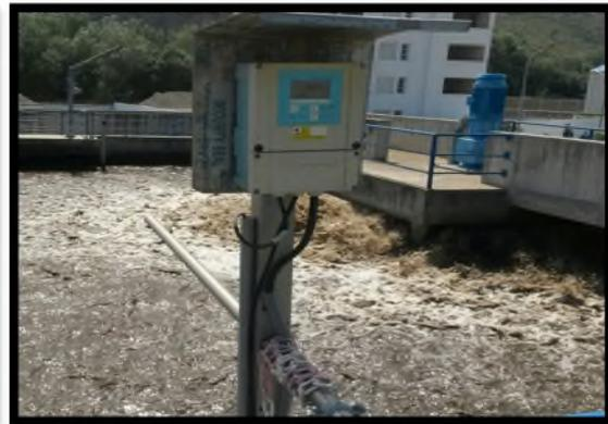
**Figure I.10 :** Oxymètre
