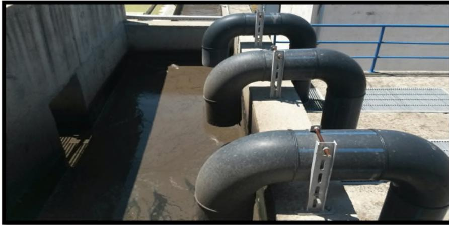
**Figure I.13:** Bassin de recirculation des boues
