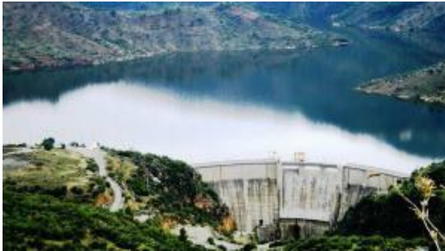
Figure IV.9 : Vue du barrage Tichy Haf (Quotedien national d'information, 2018)
