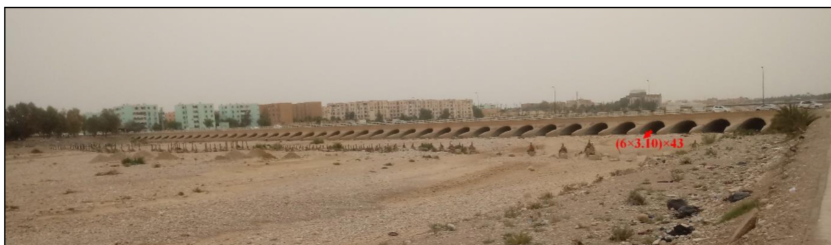
Figure IV.2: Pont N°02 (Pont busé)
