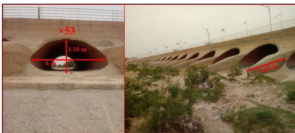
Figure IV.4: Pont N°04 (Pont busé)
