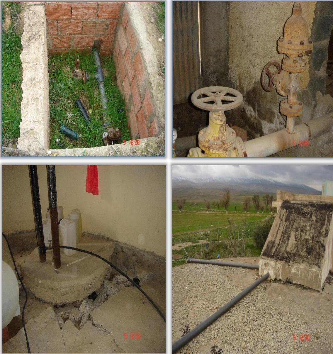
**Figure III.8-** Etat des conduites et des vannes
