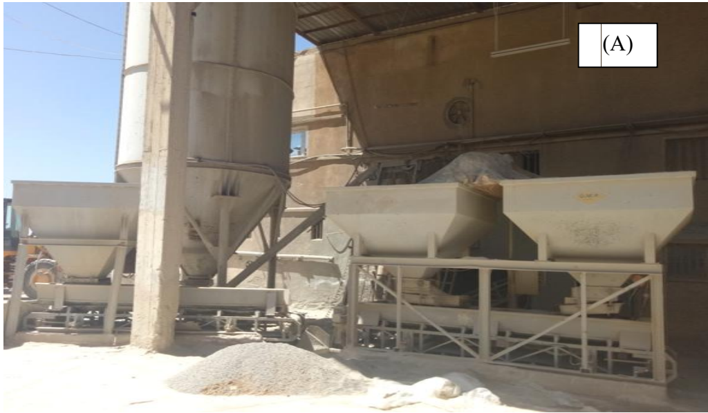
Figure I.3 Silos de stockage de matière première.
