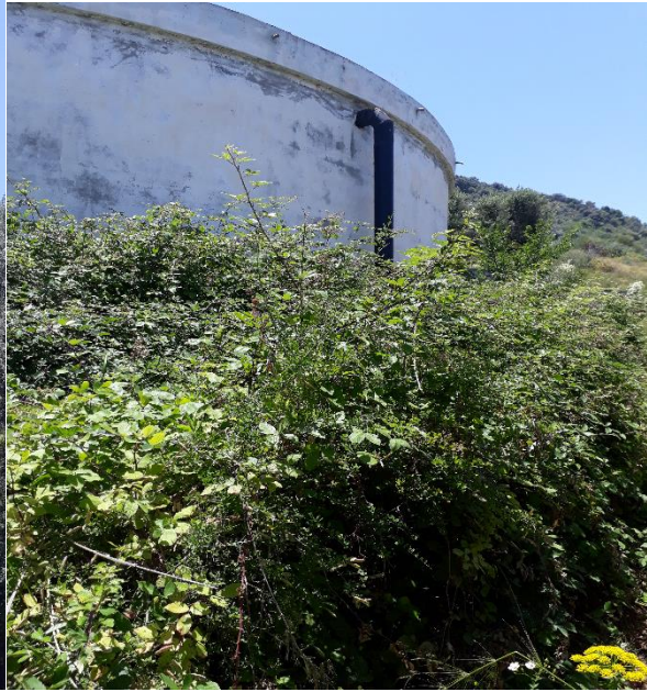
Réservoir de Sidi Naamane
