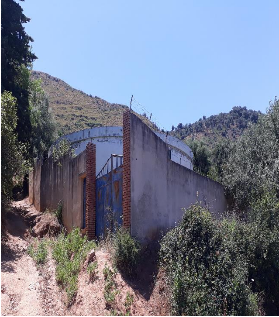
Réservoir de Ouled Ouareth
